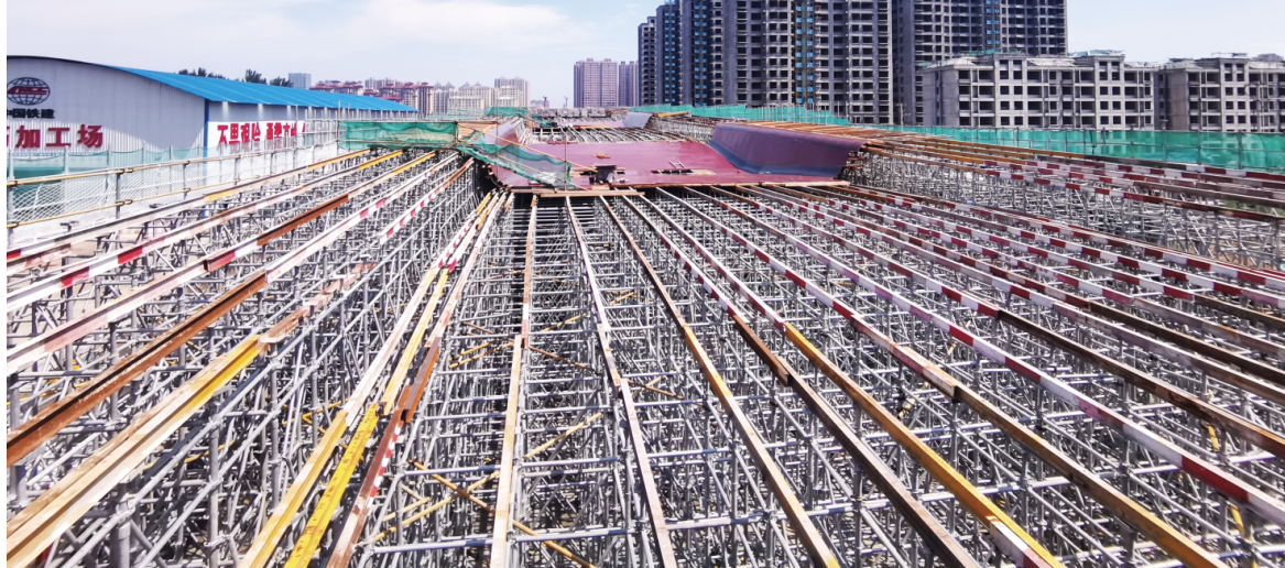
铁路南侧第一联的支架钢筋绑扎正有序施工中,为下一步现浇梁浇筑进行前期准备。
