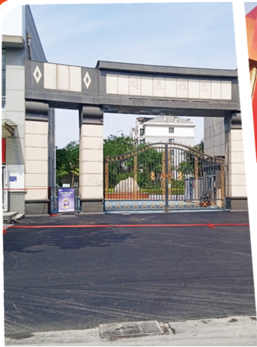
鸿泰雅园小区门口路面重铺沥青。
