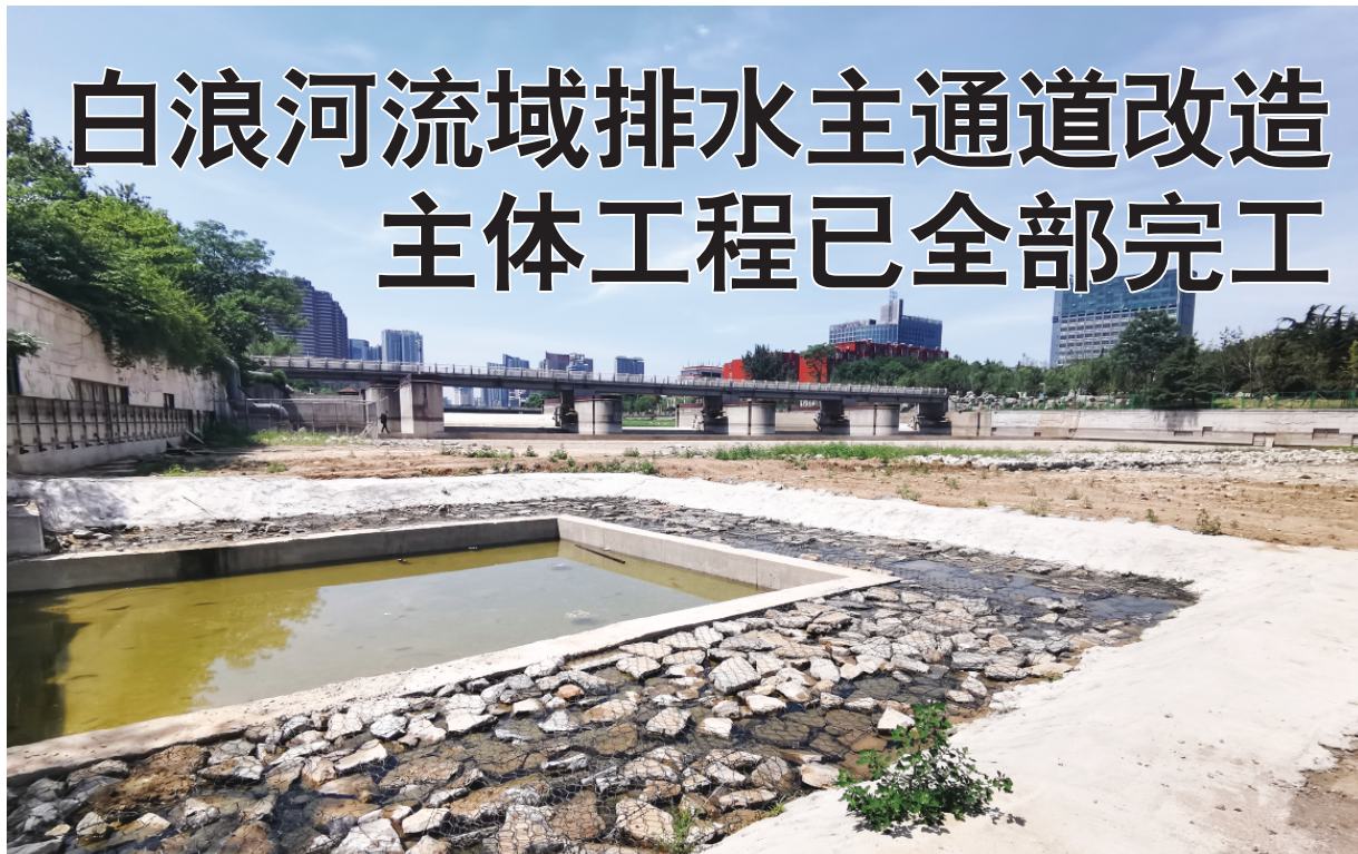
福寿街白浪河桥北侧的白浪河河道内新建的排水设施。
