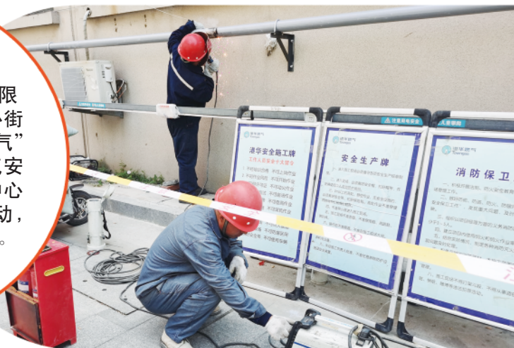
鲁发名城小区内,施工人员正在商铺墙壁上架设天然气管道。
