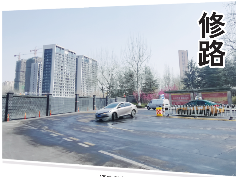
通亭街与新华路交叉口西侧120米处设置围挡。
