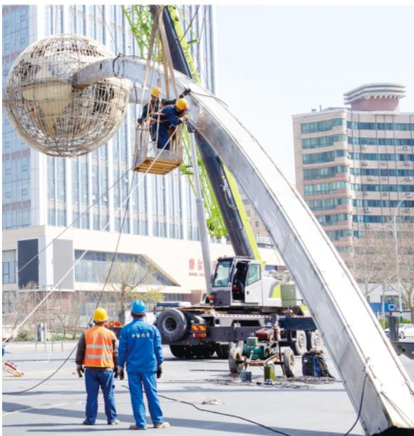
3月26日上午10时许,施工人员正拆除最后一根不锈钢拱梁。11时30分许,不锈钢拱梁全部拆完,“星球”雕塑安全落地。通讯员 李振龙
