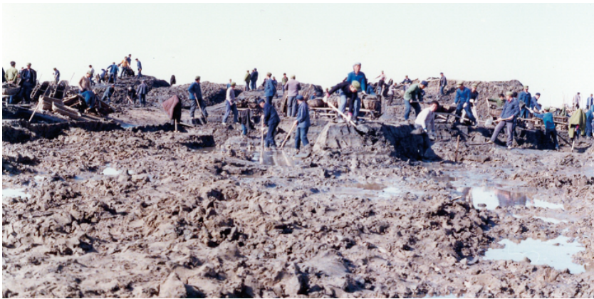
寿北开发施工现场
