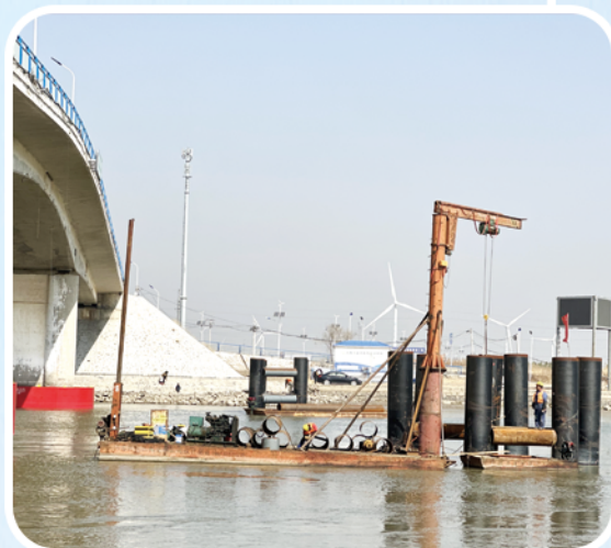
施工人员在河道内进行钢管桩施工。
