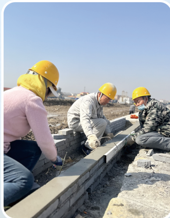
工作人员在做木栈道基础施工。
