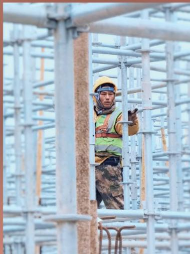
工人正在搭设满堂脚手架。
