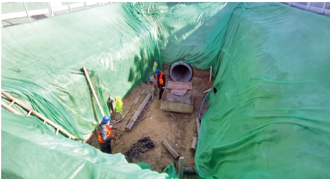
白浪河潍州湖闸坝东侧附近新建了一条直排河道的雨水管道。
