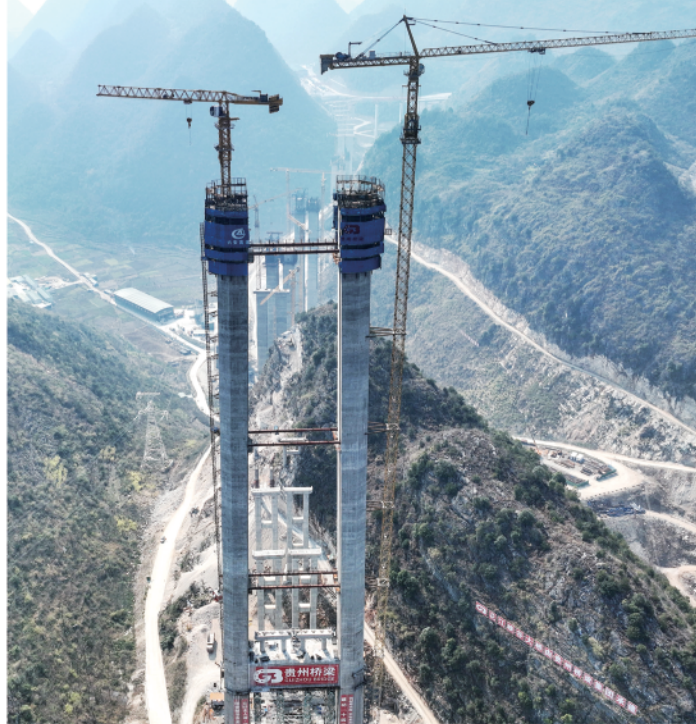
正在施工中的花江峡谷大桥
