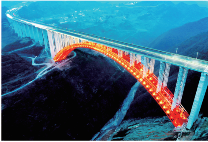
夜幕下的大发渠特大桥
