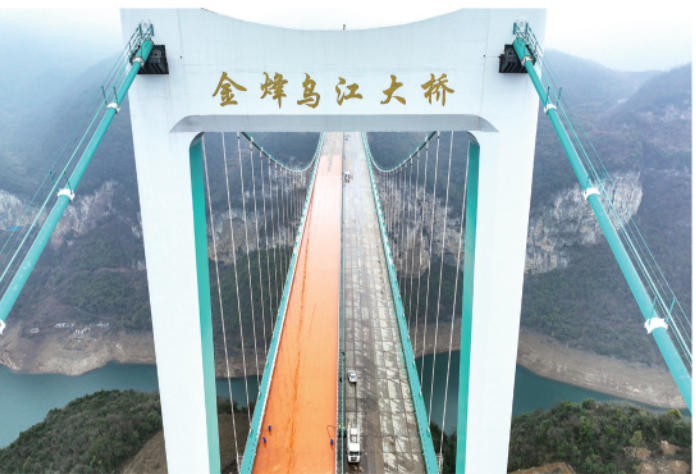
贵州金峰乌江大桥
