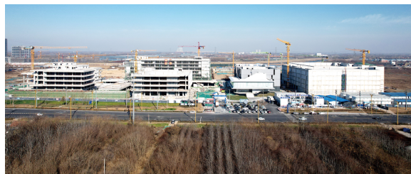
山东环渤海算力中心项目建设场地
