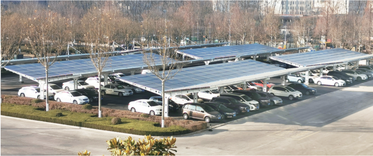
坊子区政府车棚光伏发电项目建成效果。
