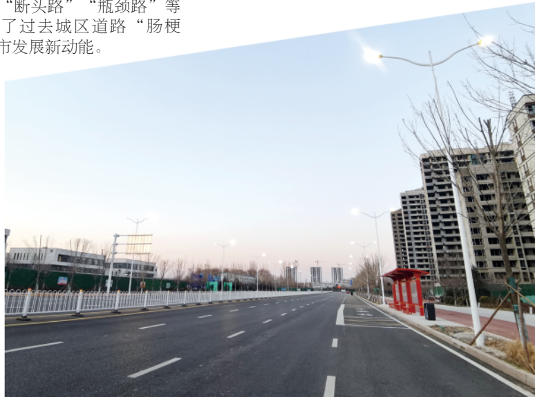
新华路泰祥街至古亭街路段被打通,建设标准非常高。
