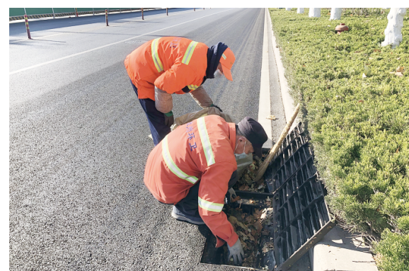
在潍城区北官西街与清平路交叉口西侧,环卫工人正在清掏雨水井箅子。
