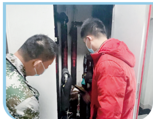
物业工作人员检查张女士家的供暖管道。
