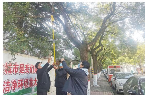
10月26日,记者在奎文区广安巷看到,奎文区综合行政执法局数字化综合执法指挥中心工作人员正手拿黄色长杆,整治空中飞线。长杆顶部有个“夹子”,把“夹子”伸到松散杂乱的线缆中,按动按钮后,“夹子”立刻就自动夹了一下,原本杂乱的线缆被绑在一起,显得规整多了。
