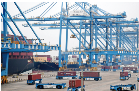
作业中的山东港口青岛港全自动化集装箱码头
