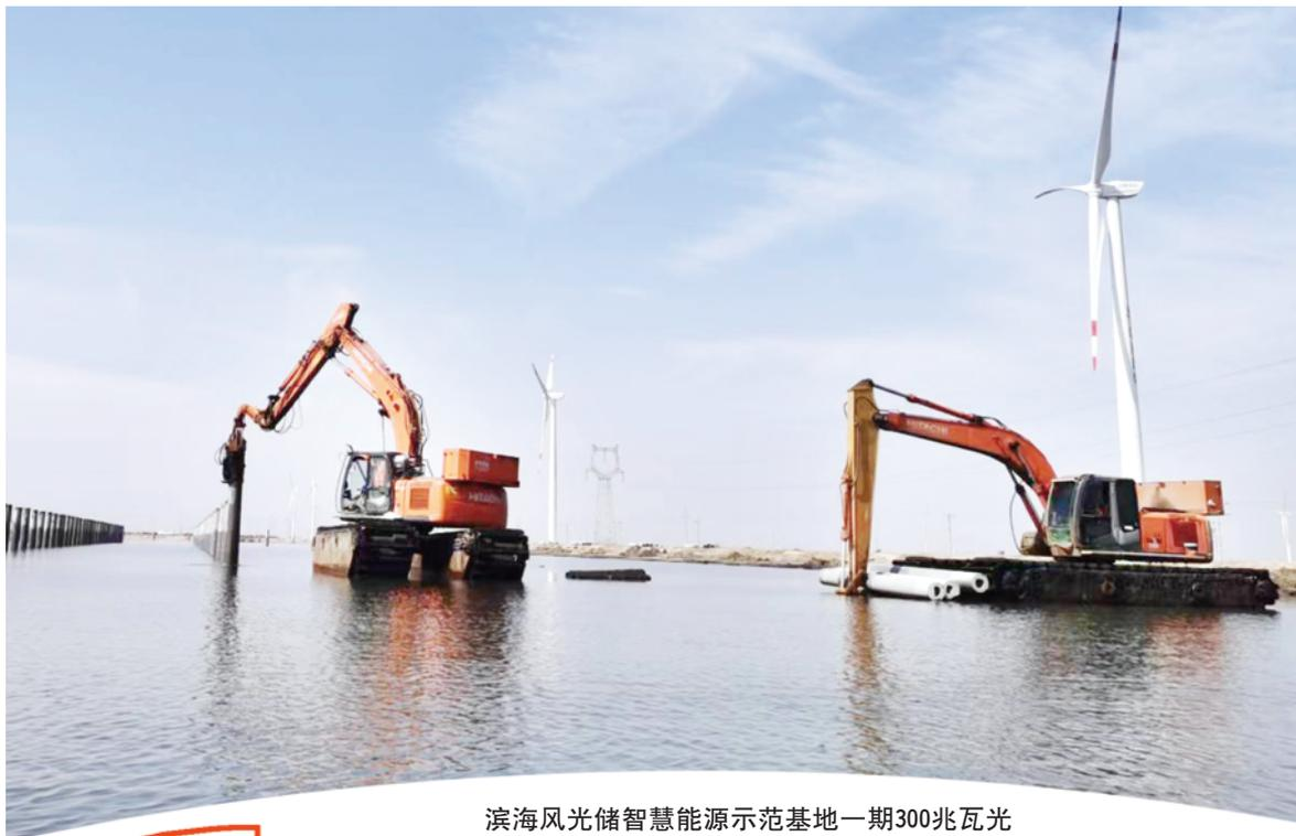
滨海风光储智慧能源示范基地一期300兆瓦光伏发电项目现场,工人正在进行桩基施工。
