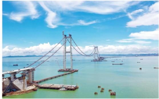
10月16日，深中通道关键控制性工程伶仃洋大桥的建设现场。
