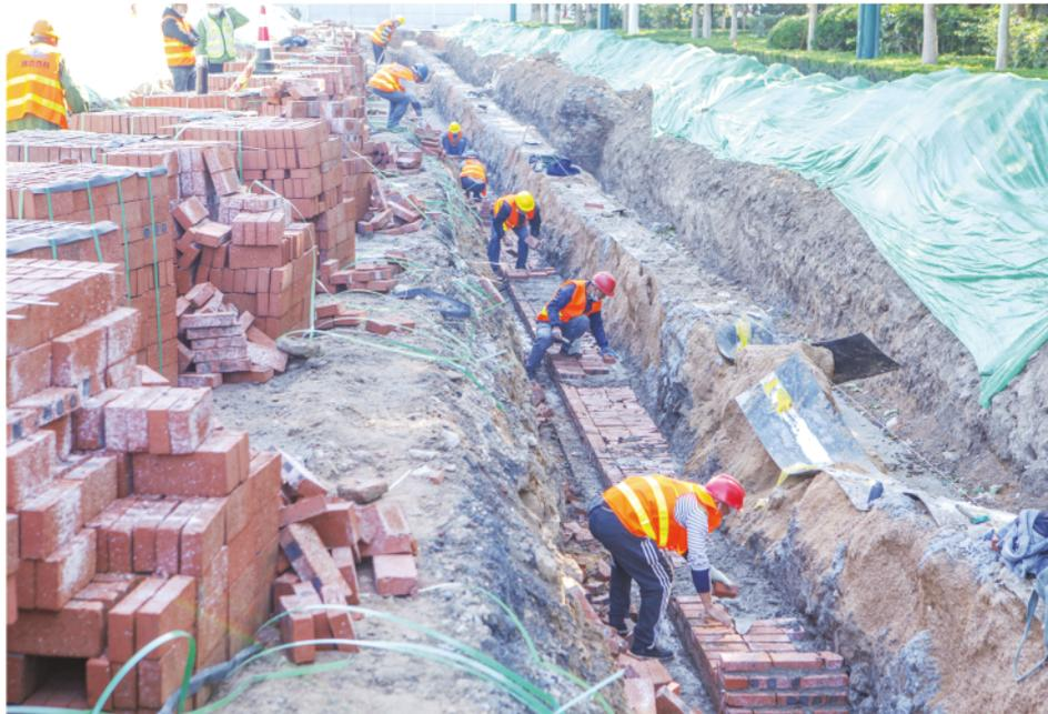
施工人员对北宫西街翻建路段的燃气管道进行施工前保护。
